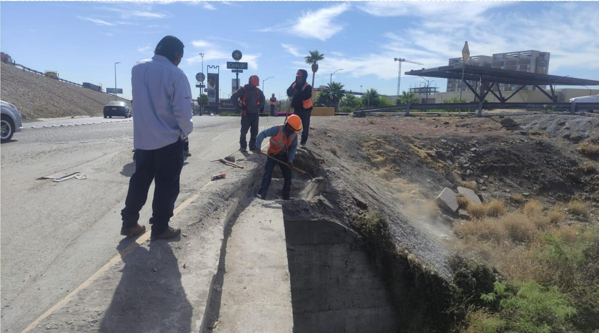
**Se realiza excavación para Zapata a un lado del canal.**
